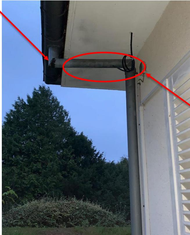
*La descente en zinc naturel ne possède pas la pente nécessaire à l'évacuation de l'eaux pluviales. Risque d'engorgement.*
